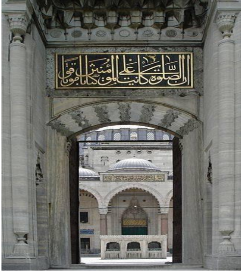
Cami avlusuna giriş kapısı
